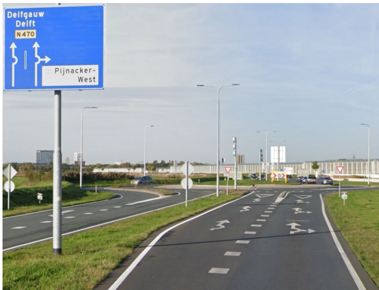
Figuur 3 Strookwegwijzer en wegdekpijlen bij een turborotonde N470 - Google Maps
