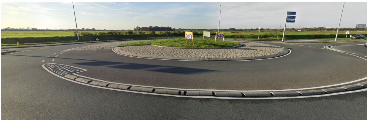
Figuur 2 Overrijdbare rijbaanscheiding met druppelvormige start bij een turborotonde (Pijnacker) Pijnacker - Google Maps ,
